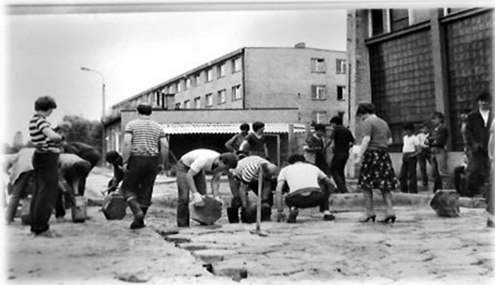
1984/85 budowa zatoczki autobusowej
